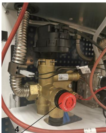
Рис. 25 Демонтаж предохранительного клапана
